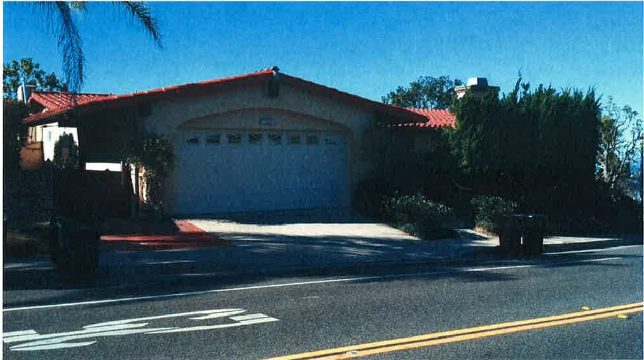
300 Avenida San Pablo
