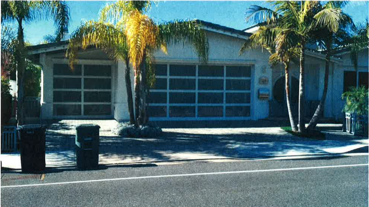
304 Avenida San Pablo
